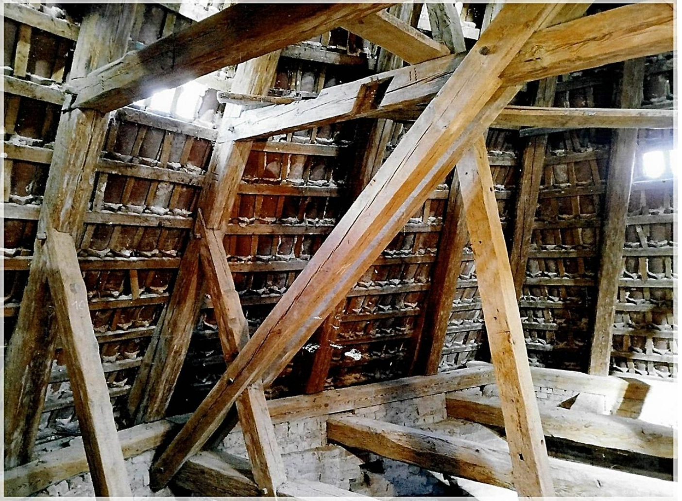
Wtórna wzmocnienia, ubytek elementu i znaki ciesielskie
