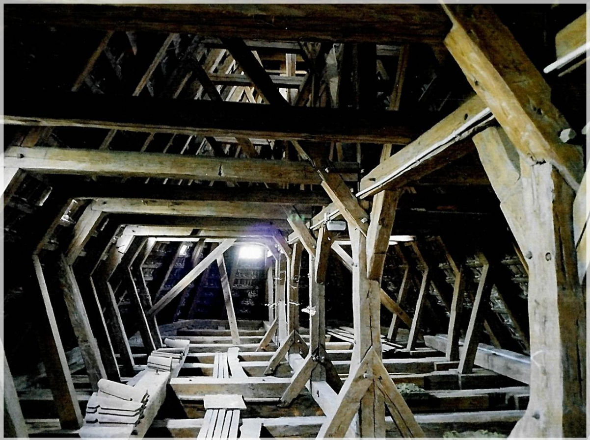
Widok ogólny więźby dachowej nad prezbiterium w kierunku wschodnim
