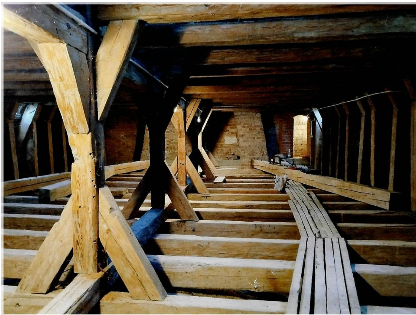
Widok ogólny więźby dachowej nad nawą w kierunku zachodnim
